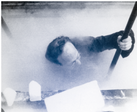
Hartecks Trockeneisreaktor in Hamburg: Bestückung einer doppelwandigen Holzkiste mit Kohlesäureblöcken
